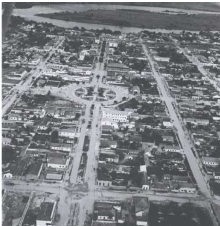
FIGURA 3 - Vista parcial da área central, com a Praça Serra Lima, década de 1950. Fonte: Arquivos do Cedac/Univale.
