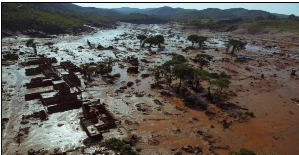
Figura 6 - Distrito de Bento Rodrigues após o rompimento da barragem de Fundão.
