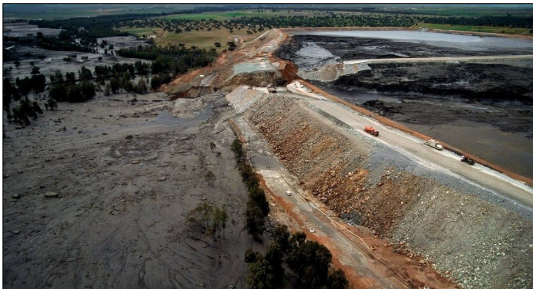
Figura 4 - Barragem de Aznalcóllar (Espanha) e trecho do rompimento.
