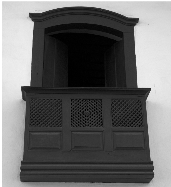
Figura 5 - Janela com verga curva e guarda-corpo trelçado (Santana de Parnaíba/SP). Fonte: Autor (2013).
