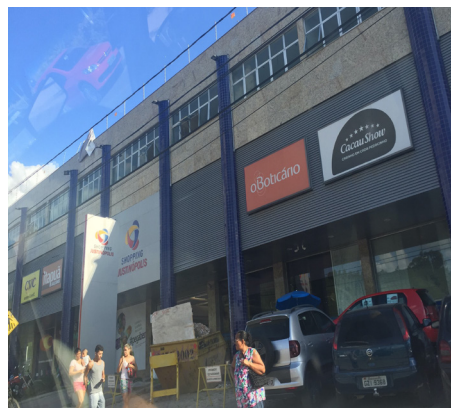
Figura 3 | Equipamentos comerciais em Nova Lima Fonte: Elaborado pelo autor, 2020.
