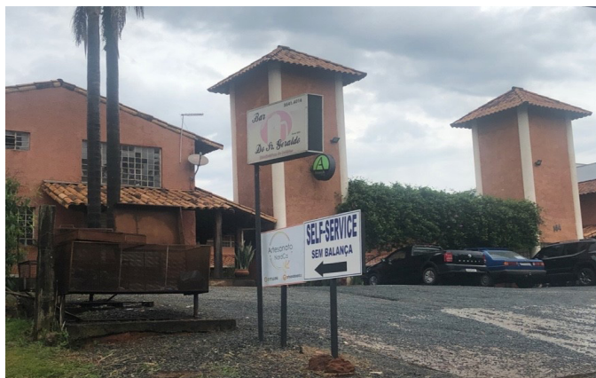
Figura 3 | Equipamentos comerciais em Nova Lima Fonte: Elaborado pelo autor, 2020.
