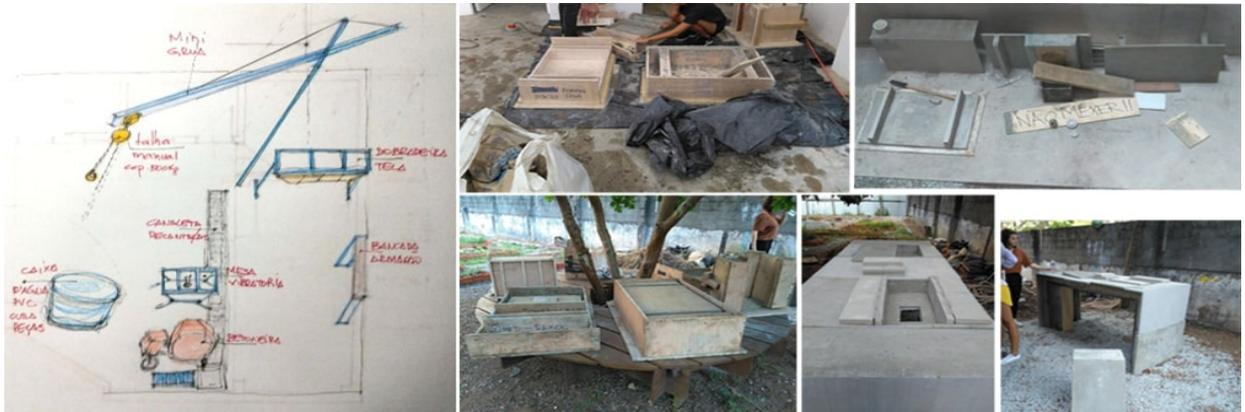
**Figura 5:** À esquerda, croquis de concepção da área de concretagem e de argamassa armada da Fábrica-Escola de Humanidades João Filgueiras Lima. À direita, mobiliário urbano para área de lazer: bancada para churrascueira e cuba. Na sequência da esquerda para a direita e de cima para baixo: componentes fundidos em forma de madeira, componentes desformados, formas dispostas no local de implantação para discussão com a comunidade, visão superior e externa da peça montada apresentada à comunidade.
