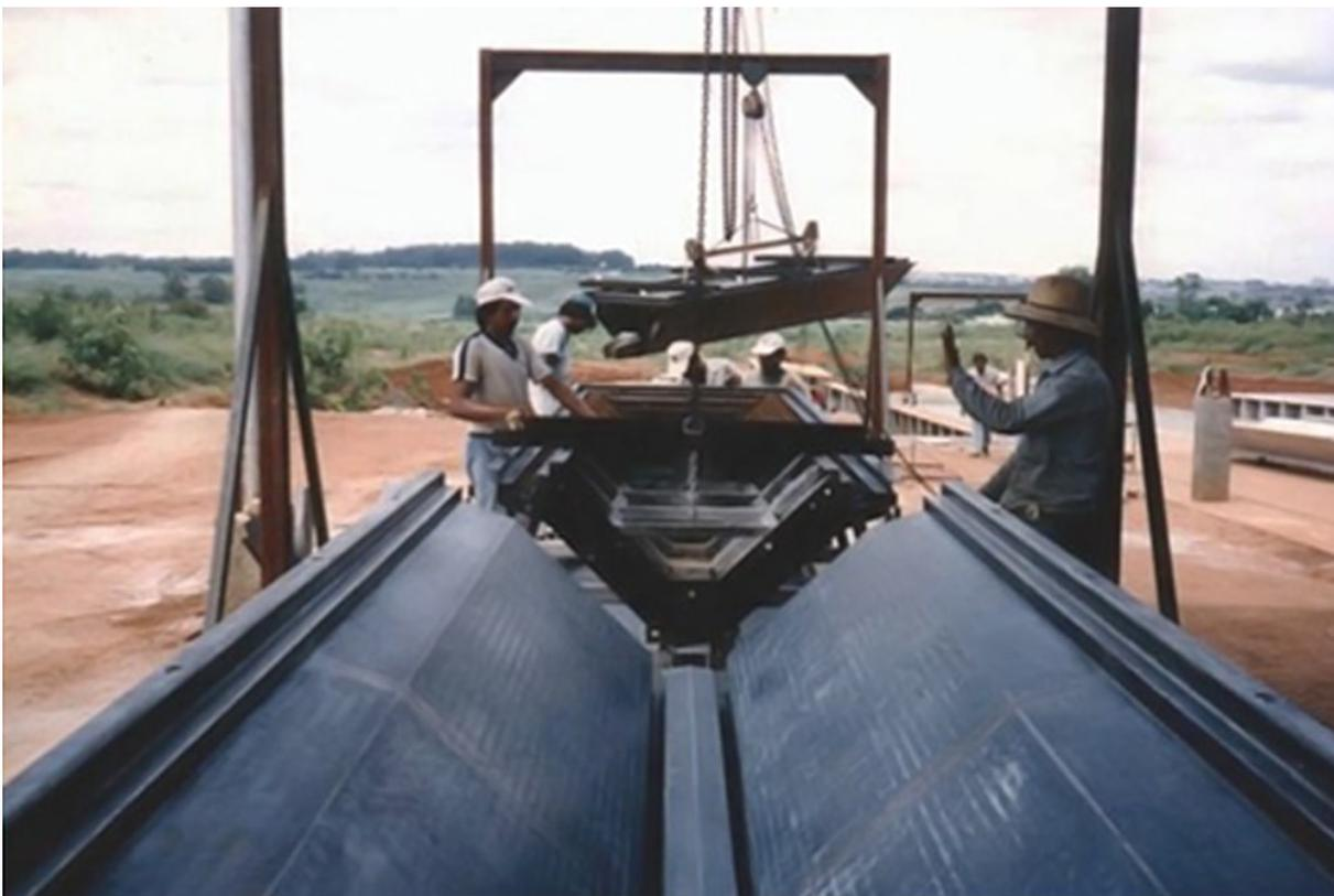
**Figura 1:** Forma de viga sobre o tanque de primeira cura.
