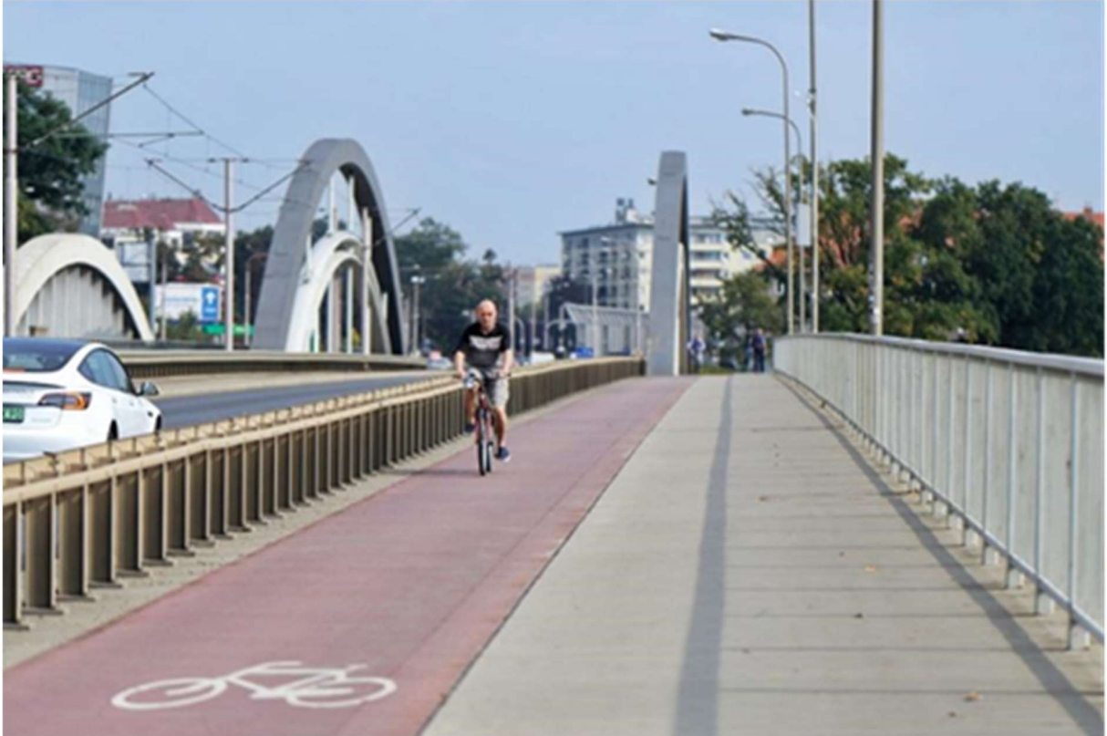
Figura 4: Faixas destinadas ao deslocamento seguro de ciclistas.
