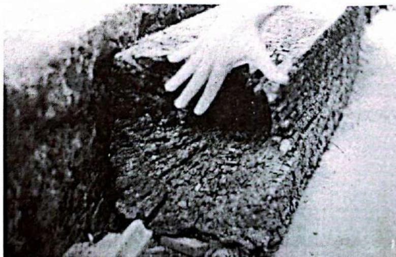
Foto 11 – Esteio retirado da capela do carmo em Diamantina, mostrando seu interior totalmente destruído pelo ataque de cupins.
