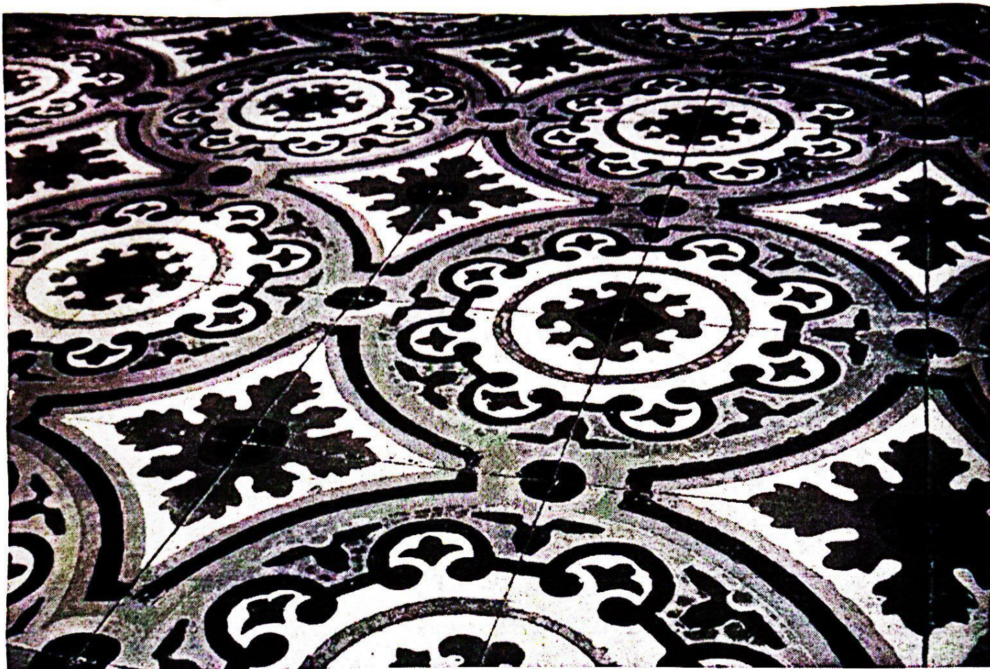
Piso em ladrilho hidráulico – Hall prédio 3
