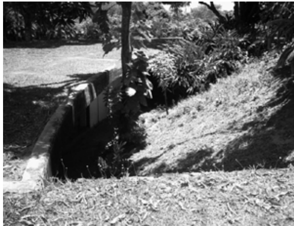
FIGURA 6 – Talude e teto gramado do anexo da igreja. Foto do autor.
