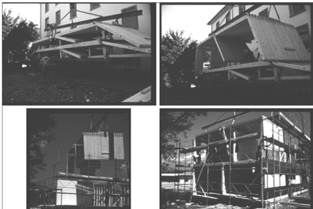
FIGURA 7 - Associação de piso com vedação vertical por sistema dobrável, que utiliza painéis pré-moldados de madeira. Principado de Liechtenstein. Fonte: Hilti, 2004b.
