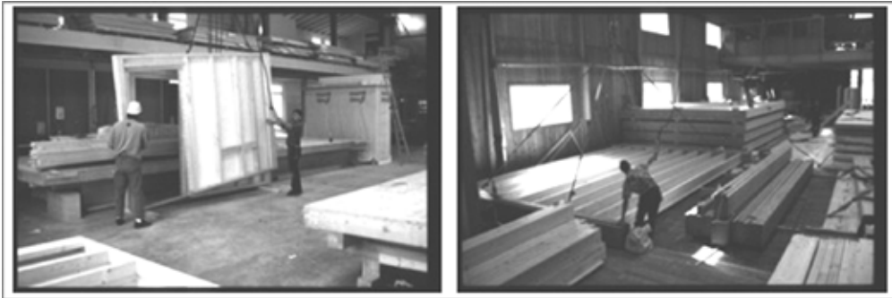
FIGURA 6 - Planta industrial para fabricação de componentes estruturais e painéis pré-moldados de madeira de reflorestamento. Principado de Liechtenstein. Fonte: Hilti, 2004a.
