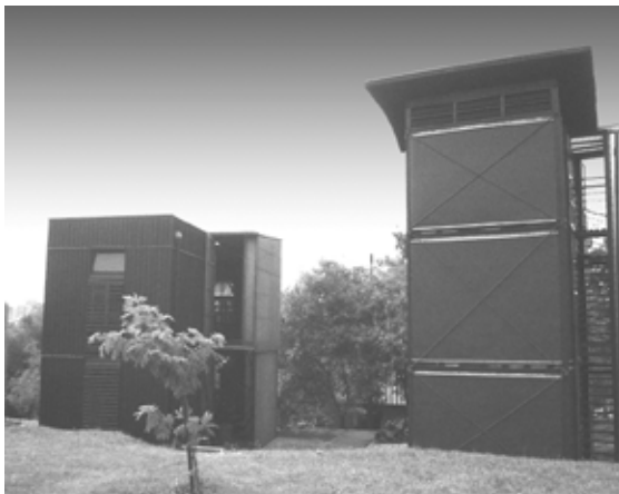
FIGURA 2 - Unidades experimentais que utilizam painéis de madeira. Campus da Universidade de São Carlos, SP. Foto: Cristiana Cota Salomão.
