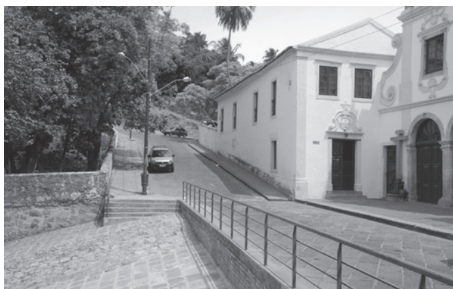
Figura 16 • Desnível entre a rua e o pátio após as escavações. Fonte: fotografia do autor, 2008.
