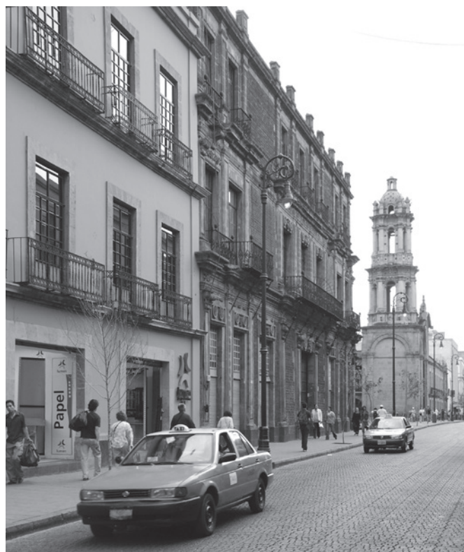
Figura 8 • Perspectiva da Rua República de El Salvador, com destaque para a torre do complexo do Oratório de São Felipe Néri. Fonte: fotografia do autor, 2009.
