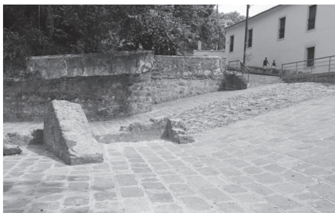
Figura 17 • Desnível entre a rua e o pátio após as escavações; escombros. Fonte: fotografia do autor, 2008.
