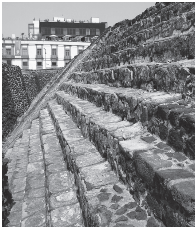
Figura 1 • Uma das etapas construtivas da pirâmide do Templo Mayor revelada nas escavações. Fonte: fotografia nossa, 2009.
