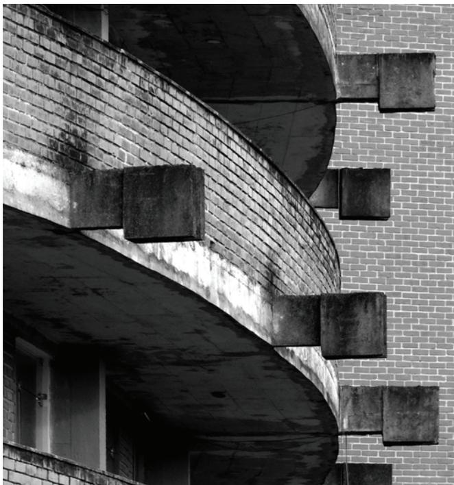
Figura 6 • Vista da circulação externa com os andares e os consoles que sacam da estrutura principal. Foto do autor.
