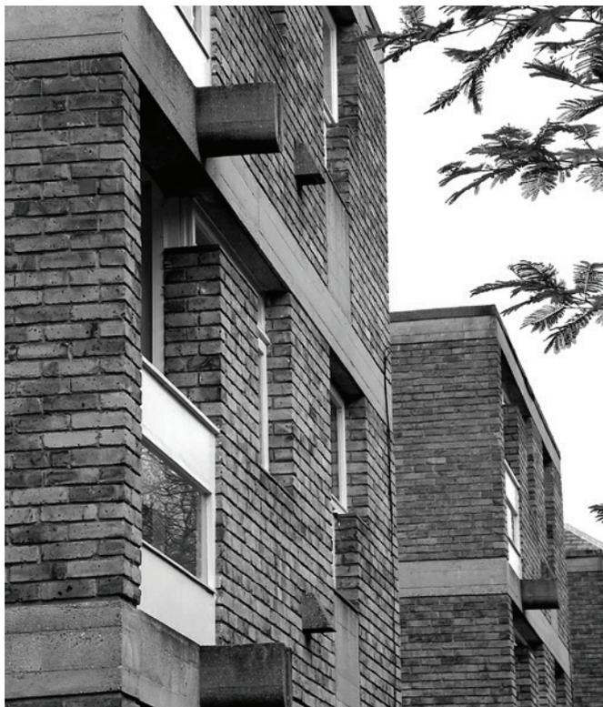
Figura 7 • Detalhe dos consoles de concreto e das vedações em tijolo do *Ham Common Flats*, James Stirling, 1955. Foto do autor.
