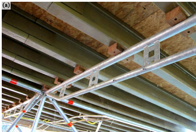
Figura 13a | Calço de madeira adaptado entre a viga ponte e as vigas H20. Fonte: Acervo do autor e http://www.studioveneziano.com.br/
