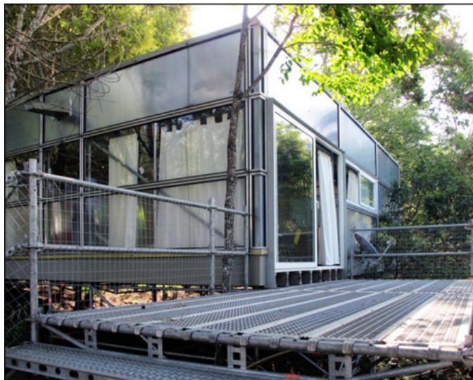
Figura 11a | Edificação permanente executada com estrutura de andaime multidirecional, implantada em um terreno acidentado. Fonte: Acervo do autor.
