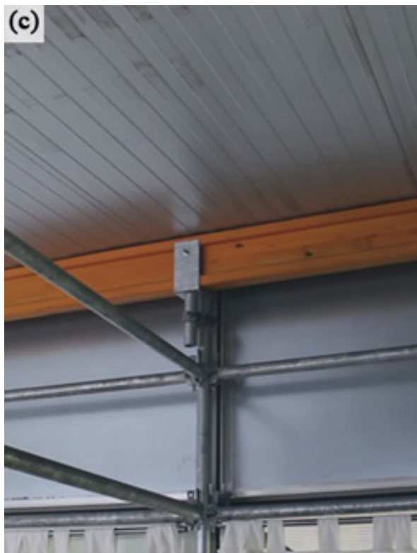
Figura 12c | Forcado metálico com a viga H20 que apoia as telhas sanduíche.
