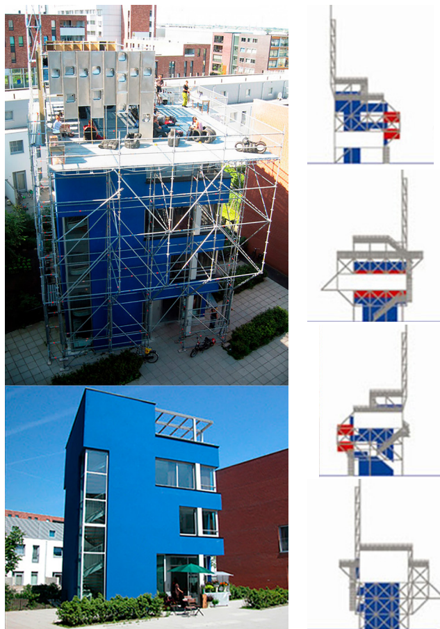
Figura 07 | Pump up the blue house , 2007- Andaime multidirecional acoplado à edificação convencional para acréscimo temporário de área útil. Ao final do período de uso, a edificação retoma sua forma original. Fonte: http://www.jeannetworks.net/projects/the_blue_house/
