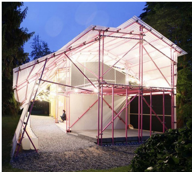
Figura 8a | Pavilhão-Escola Hamlet, 2015- Edificação permanente, sistema construtivo a partir de estrutura de andaime tubo e braçadeira. Fonte: http://www.archdaily.com/782058
