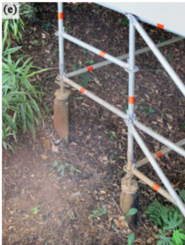
Figura 12e | Fundação com estaca de eucalipto. Fonte: Acervo do autor e http://www.studioveneziano.com.br/
