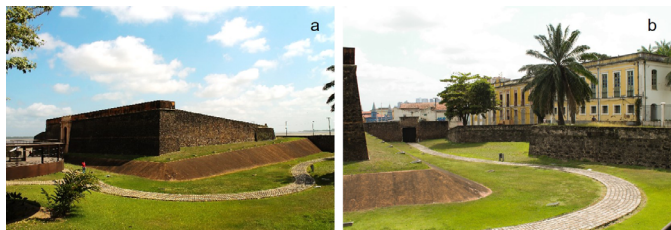
Figura 7: Imagens do Fosso do Forte: (a) Vista geral do Fosso com ampla área gramada e Forte ao fundo; (b) Caminho pavimentado interrompido pelo portão
