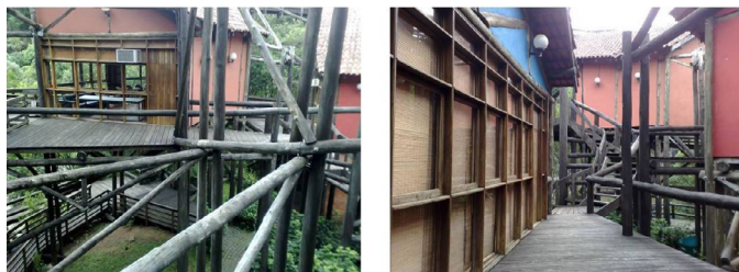
Figura 2 | Detalhes da passarela acessando o interior do conjunto Fonte: Original Autores
