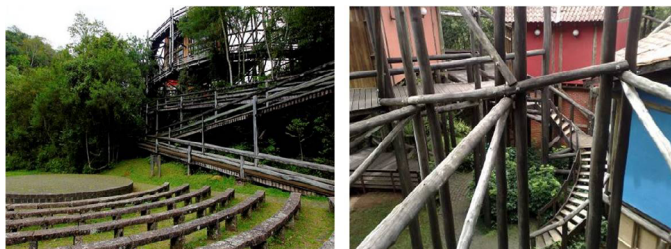
Figura 1 | Estrutura em troncos de madeira da rampa externa (a) e da escada interna (b) Fonte: (a) Arquivo Gazeta do Povo (GAZETA, 2017a); (b) Original Autores
