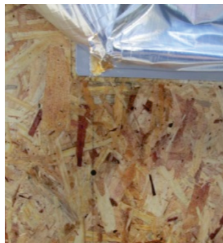
Figura 27 | Identificação da falha na membrana de impermeabilização.
