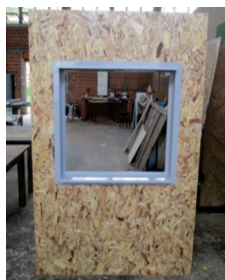
Figura 22 | Painel com as placas solidarizadas e vão luz definido, na sequência com o marco
