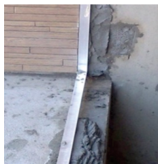
Figura 1 | Aplicação da esquadria com contramarco.
