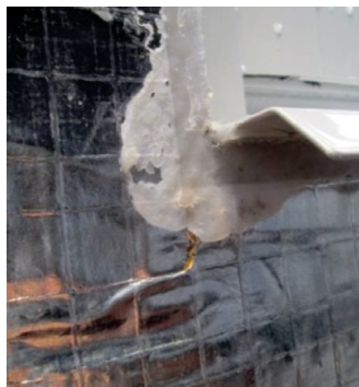
Figura 26 | Identificação da falha na membrana de impermeabilização.
