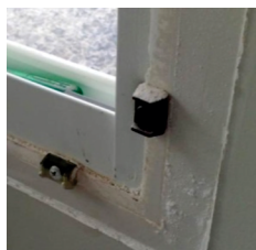
Figura 2 | Aplicação da esquadria com contramarco.
