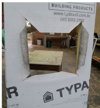
Figura 28 | Aplicação da membrana hidrófuga.
