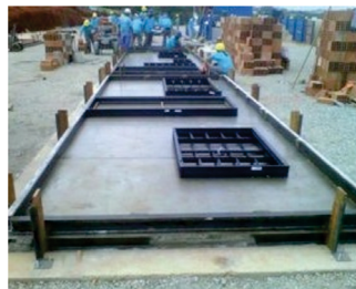
Figura 7 | Painel de concreto armado com fixação dos caixilhos.
