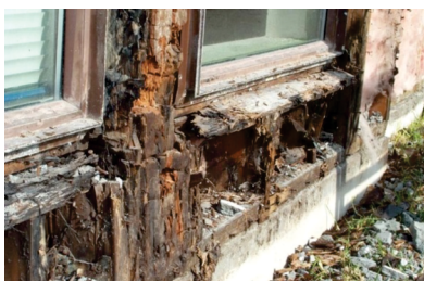
Figura 13 | Apodrecimento da estrutura de madeira.
