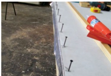
Figura 25 | Aplicação da placa cimentícia sobre o painel. Fonte: Autor (2015)
