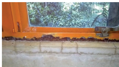
Figura 12 | Infiltração na base da esquadria provocou oxidação.
