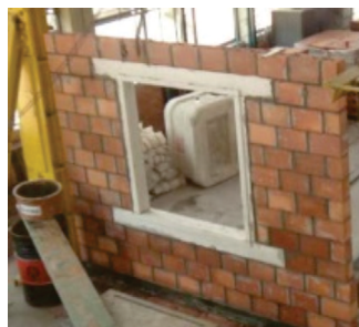
Figura 15 | Proposta de elemento para interface da esquadria x alvenaria. Fonte: Moch, (2009)
