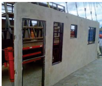
Figura 6 | Painel de concreto armado com fixação dos caixilhos.
