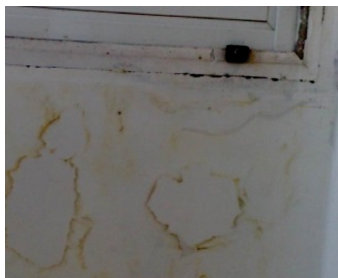
Figura 11 | Infiltração, interface esquadria x parede.
