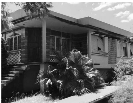
Figura 7 A e B Edificações do estilo Modernista
