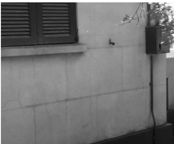
Figura 5 A e B Segunda edificação em alvenaria
