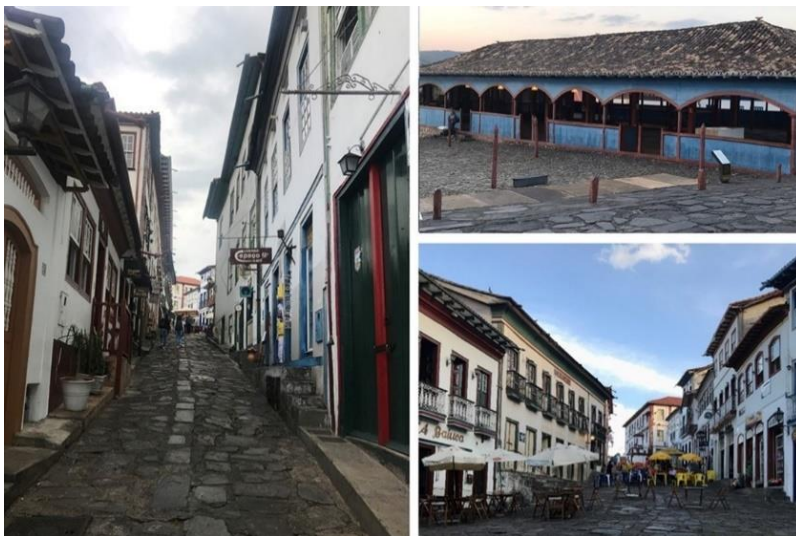
Figura 1 Sequência de edificações do Centro Histórico de Diamantina, MG Fonte: Arquivo pessoal dos autores
