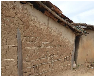
Construção em taipa de mão em Bom Jardim da Prata. Fonte: Amaro Sérgio Marques, 2015.
