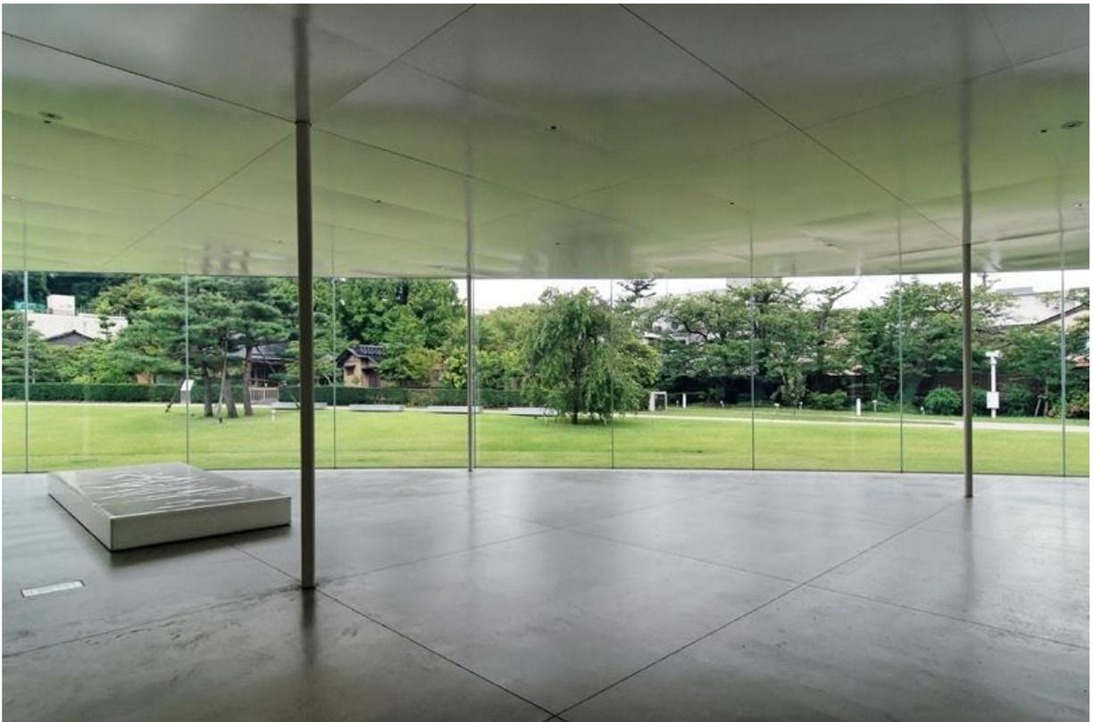
**Figura 11:** Pilares da zona pública com diâmetros afinados ao máximo, neutralizam praticamente a presença da estrutura.
