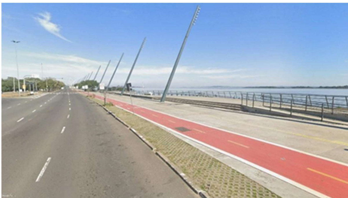
Figura 6: Construção de infraestrutura destinada aos ciclistas em Porto Alegre.
