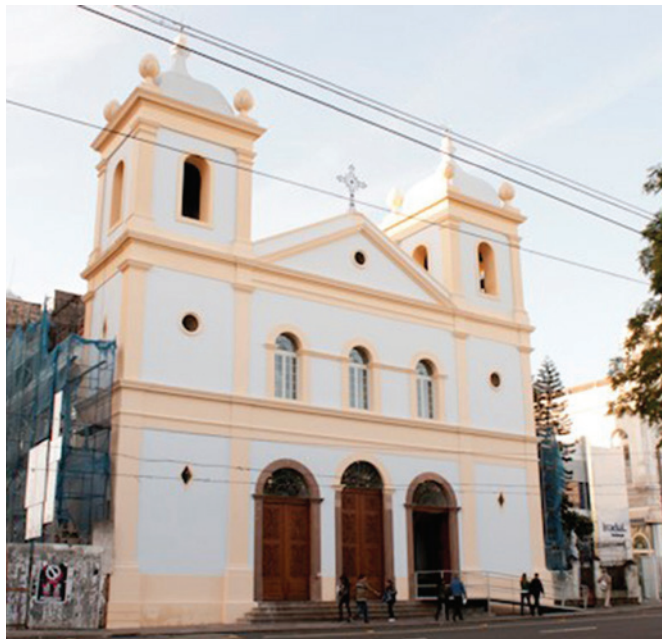
Figura 4 • Rampa de acesso e restauro da fachada
