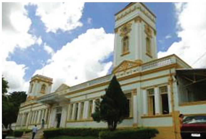
Figura 4 • Estação de Araxá, atual sede da Fundação Cultural Calmon Barreto
