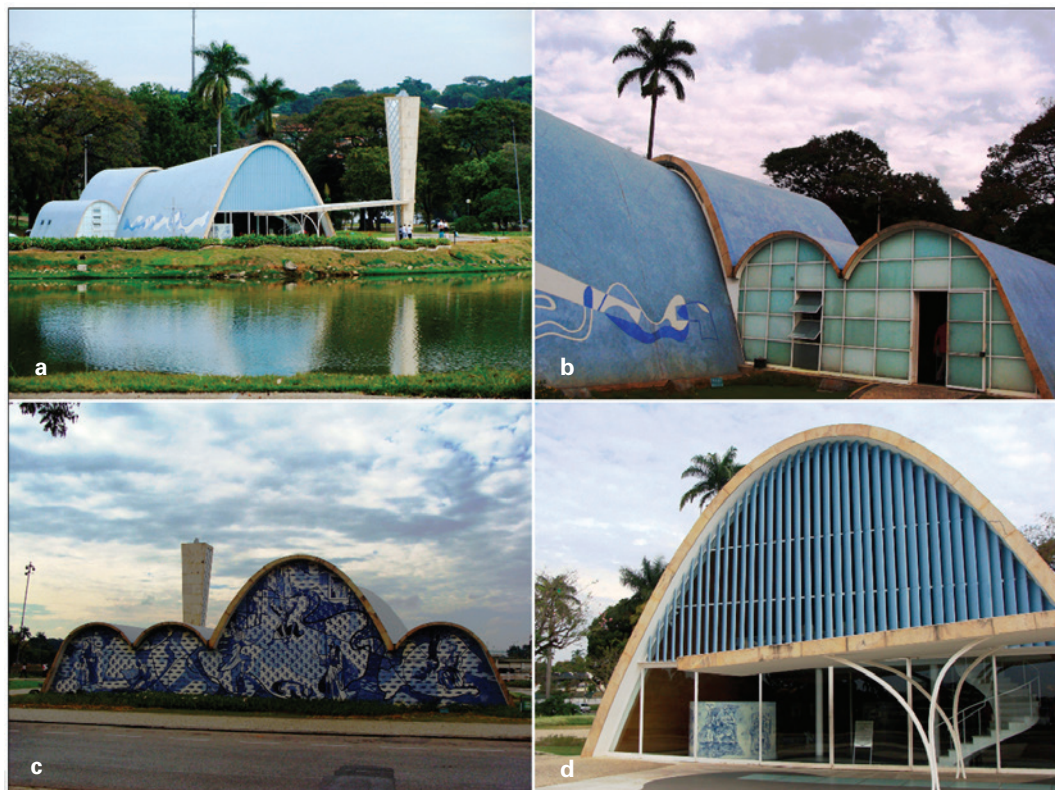
Figura 4 • Capela de São Francisco de Assis. a. vista da capela junto à Lagoa da Pampulha, com destaque para as abóbadas centrais de seções variadas. b. tomada aproximada do desnível de elementos arquitetônicos e estruturais que permitem a entrada de luz para o interior da capela. c. fachada posterior da obra, com arte em azulejaria concebida por Cândido Portinari. d. vista parcial do acesso principal, coberto pela marquise inclinada apoiada em delgados pilaretes metálicos.
