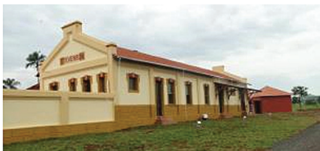
Figura 7 • Estação da Stevenson após o processo de restauro do prédio.
