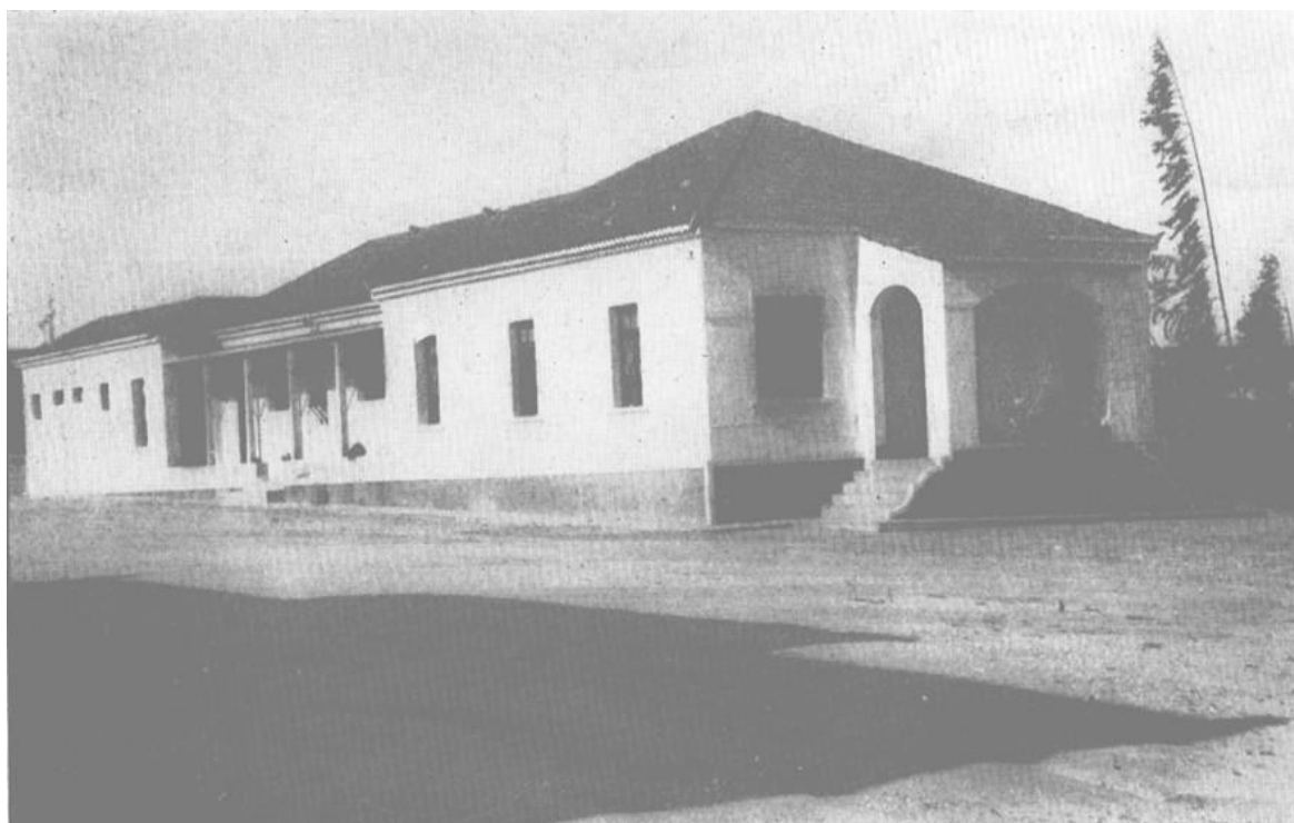
Figura 2: Prédio em que está instalado o laboratório do DFPM/DNPM em Campina Grande-PB. Fonte: Relatório da Diretoria do DFPM/DNPM de 1945, 1946, p. sem numeração.
