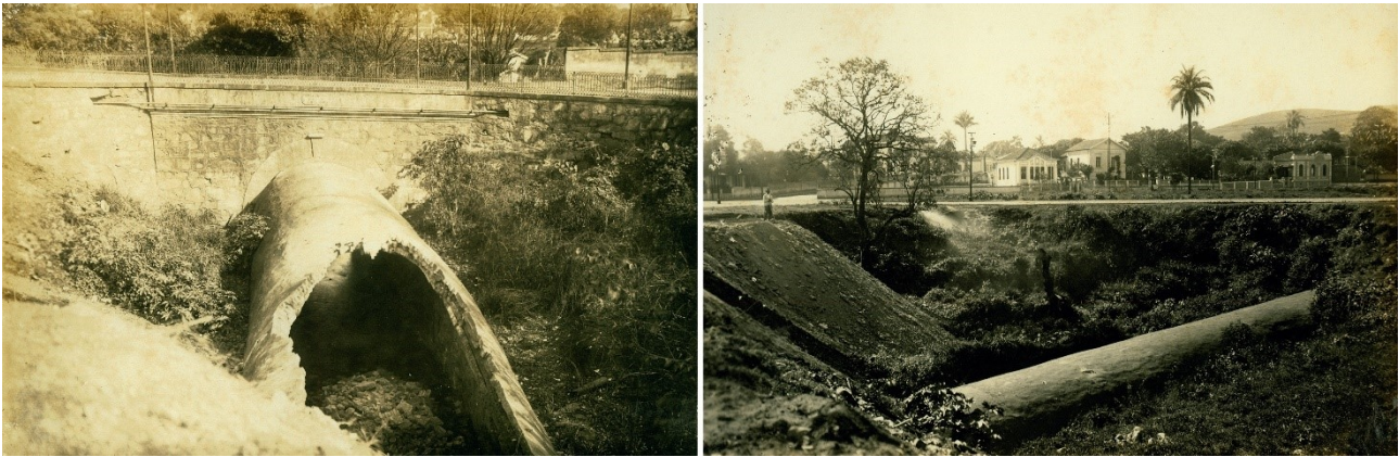
Figuras 7 e 8: Galeria de abóbada de alvenaria construída no leito natural do córrego do Acaba Mundo no ano de 1926. Detalhe para a galeria abatida na ponte da Rua Pernambuco e o aqueduto construído no leito natural, no cruzamento da Avenida Brasil e Rua Bernardo Guimarães.
