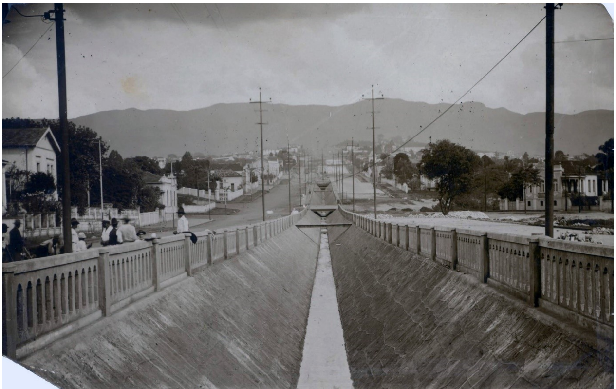
Figura 11 - Canal do córrego do Acaba Mundo na Avenida Afonso Pena, 1928. À direita o local por onde passava o antigo leito do curso d'água, em fase final de aterramento (Rua Bernardo Guimarães). Fonte: Arquivo Público Mineiro.
