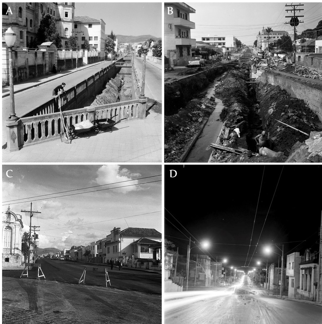
Figura 13 - Perspectivas do canal do córrego do Acaba Mundo na década de 1960: vista do canal à montante na Rua Professor Moraes, 1963 (A), obras de alargamento e aprofundamento, outubro de 1963 (B), o canal coberto no cruzamento com Avenida Afonso Pena, 1965 (C) e vista noturna da Rua Professor Moraes após o término das obras, 1965 (D).
