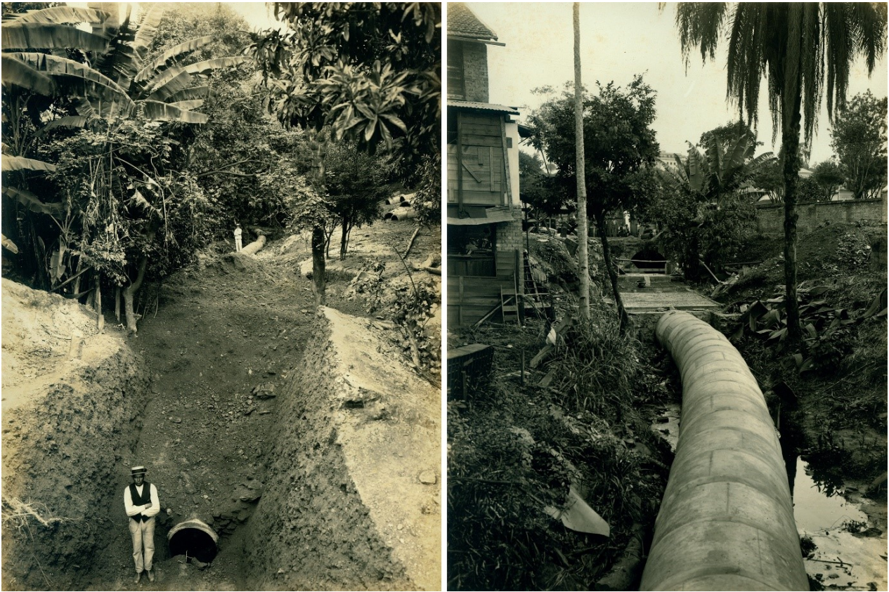
Figuras 9 e 10 - Construção do dreno e aterramento do antigo leito do Acaba Mundo no bairro Funcionários, 1928. Fonte: Museu Histórico Abílio Barreto.
