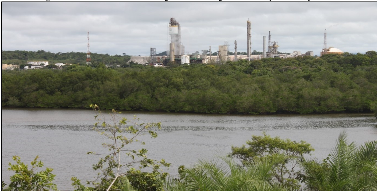
Figura 9 – Unidade da FAFEN nas margens do rio Contiguiba no município de Laranjeiras/SE.
