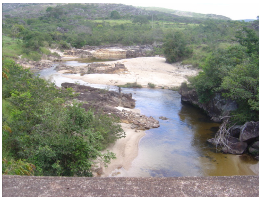
Figura 5 - Ponte sobre o Ribeirão do Inferno, assoreamento no segundo plano. Visada para norte. (Foto: Danielle Piuzana, 2010).
