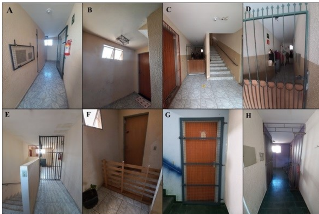
Figura 6 - Instalações de grades entre corredores, andares e apartamentos nos Residenciais Jardim das Alterosas e Vale do Sol. Fonte: SILVA (2022). (A) e (B): grades e gaiolas para a proteção de fiações e bocal; (C), (D), (E), (F) e (H): instalação e colocação de grades/barreiras; (G) instalação de grade na porta.
