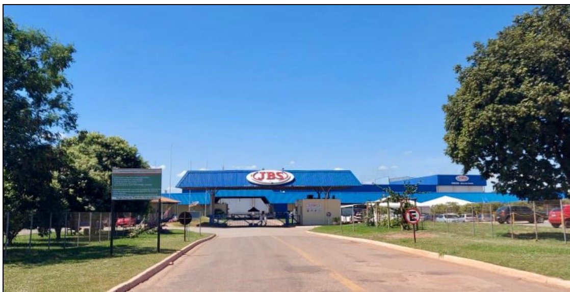
Figura 7 - Indústria frigorífica JBS S.A. localizada no município de Mozarlândia-GO, 2021.
