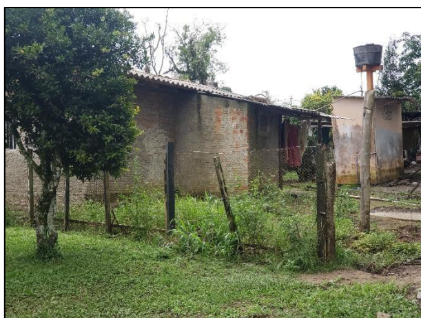
Figuras 10 e 11 - À esquerda, domicílio com instalação sanitária externa inadequada; à direita, evidência de escoamento de efluentes pelo solo do quintal, onde galinhas ciscam, ilustrando a precariedade do manejo sanitário na área 2., CRQ VEM, Lapa-PR, maio 2023.
