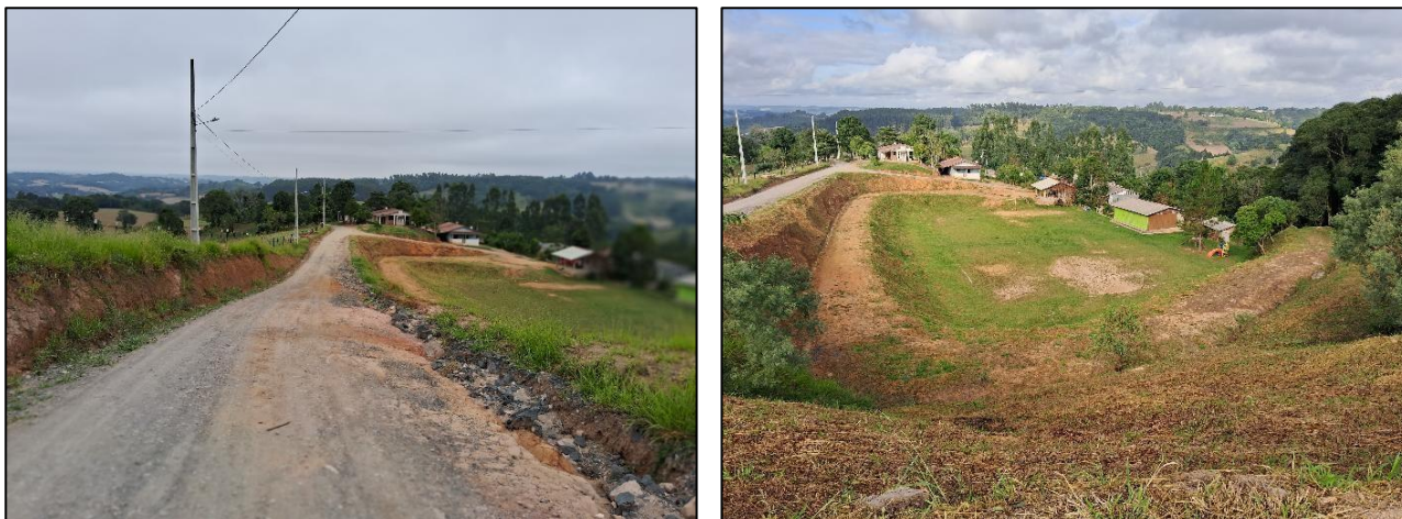
Figuras 4 e 5 - À esquerda, a Rua dos Eucaliptos, principal via da Vila Esperança, onde a ausência de drenagem adequada evidencia o risco de erosão e a necessidade de intervenções. À direita, campo de futebol da CRQ VEM, ilustrando o uso comunitário do espaço e os desafios de segurança relacionados às condições topográficas. Maio 2023. Fonte: os autores.
