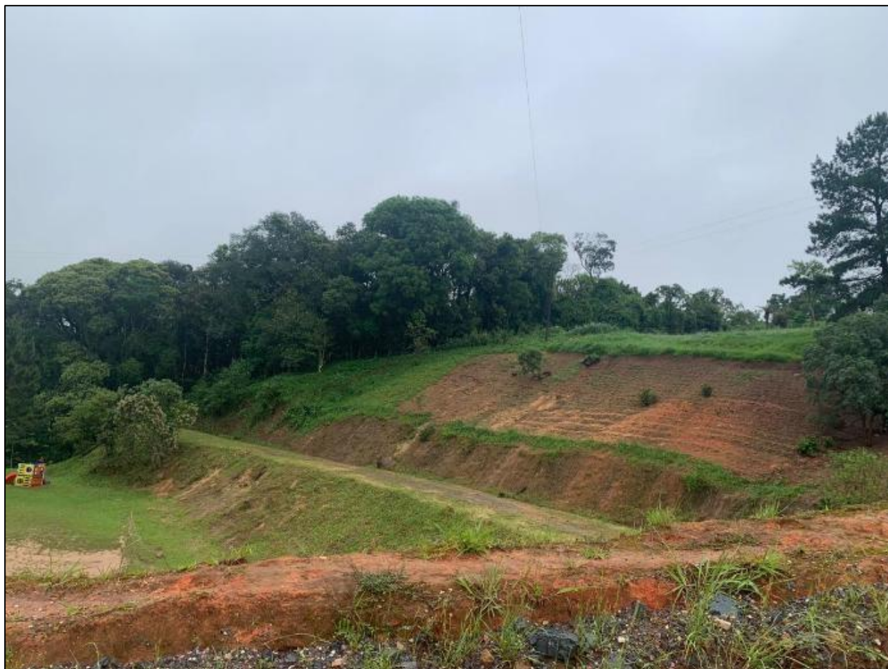
Figura 7 - Cultivo de mandioca na encosta ao norte do campo de futebol, evidenciando a ausência de práticas de manejo adequado para prevenir a erosão, CRQ VEM, Lapa-PR, set. 2023. Fonte: os autores.
