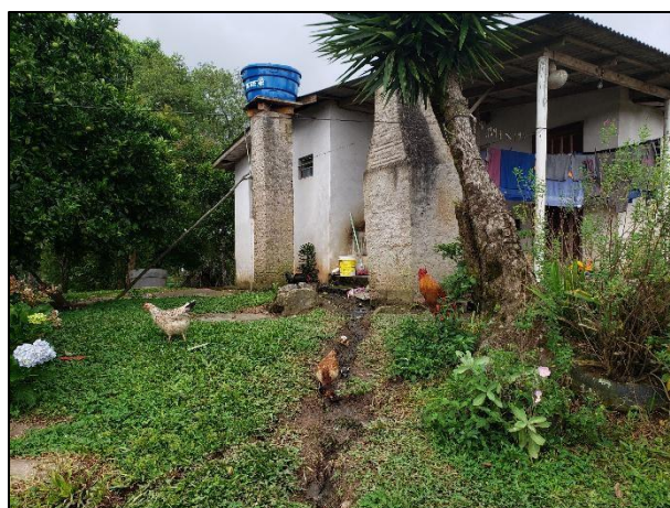
Figuras 10 e 11 - À esquerda, domicílio com instalação sanitária externa inadequada; à direita, evidência de escoamento de efluentes pelo solo do quintal, onde galinhas ciscam, ilustrando a precariedade do manejo sanitário na área 2., CRQ VEM, Lapa-PR, maio 2023.
