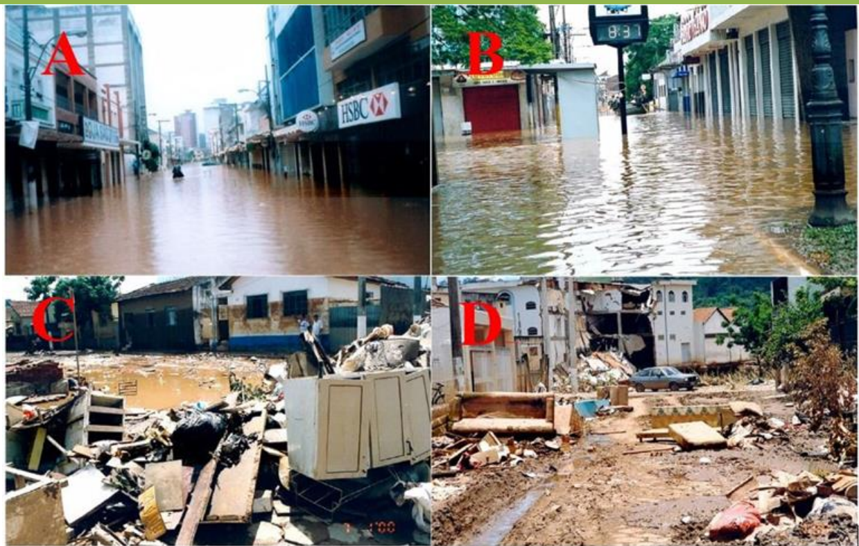
Figura 3 – Imagens A e B mostram a inundação no centro comercial, enquanto as imagens C e D apresentam a área após o evento. Fonte: Elaborado pelos autores, 2024.
