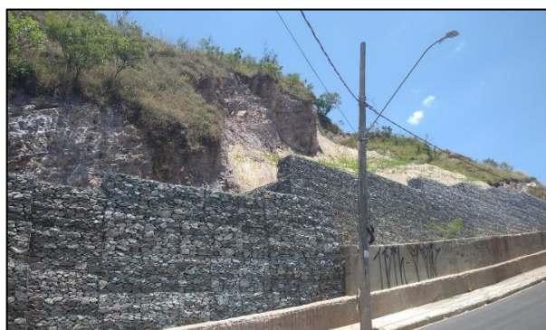
(a) Vista do talude recuperado.
