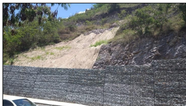
(b) Detalhe da biomanta no talude recuperado.
