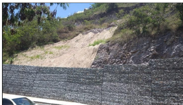
(b) Detalhe da biomanta no talude recuperado.
