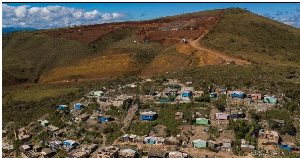
Figura 15 - Vista panorâmica da fronteira geográfica da Regional Leste com Sabará e Nova Lima. Exposição do conflito associado a expansão urbana não planejada e da mineração na região. Fonte: Flávio Tavares, 2024.
