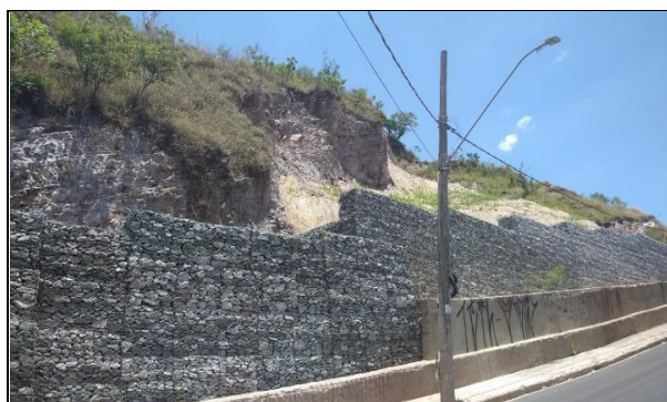
(a) Vista do talude recuperado.
