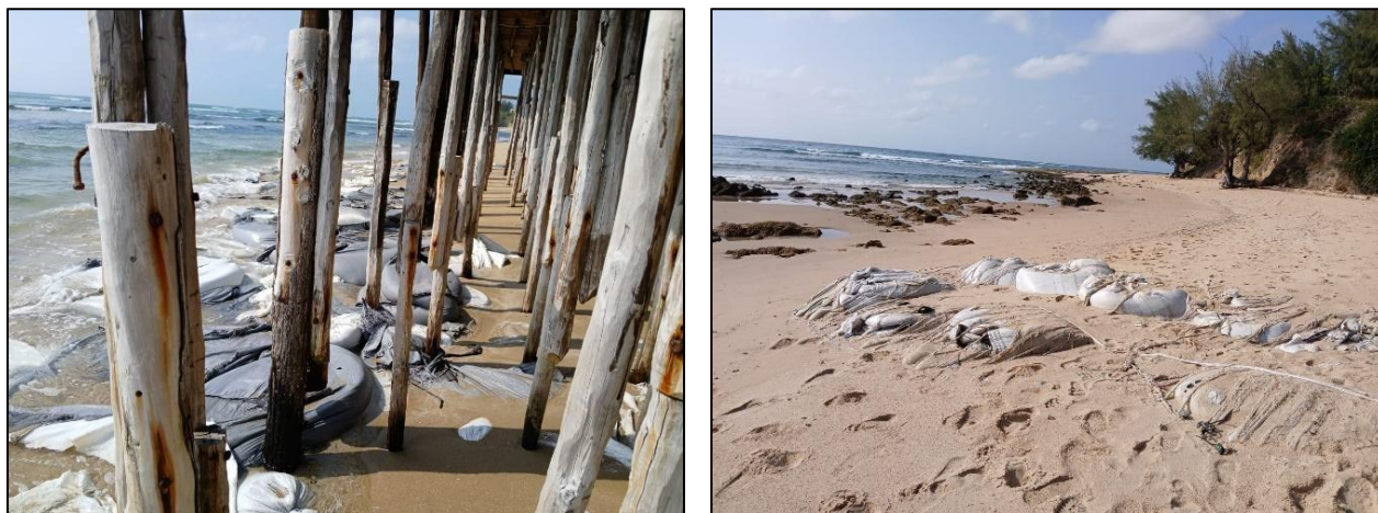
Figura 9 - Algumas das alternativas adotadas ao longo da costa (praia da Barra) para impedir a evasão das águas do mar. Fonte: Autores (2025)
