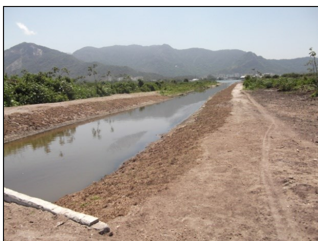
Figura 2 - Canal de esgoto na margem sul da lagoa de Jacarepaguá nos terrenos do condomínio Alpha Ville, local onde o canal de esgoto se conecta a lagoa de Jacarepaguá. Fonte: CARVALHO, 2011.
