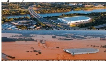
Ponte da BR386 que liga as cidades de Lajeado e Estrela (Vale do Taquari)
