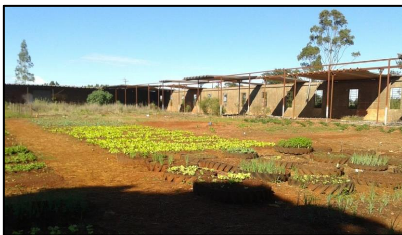
Figura 5 - Espaço da horta na terra da sala de máquinas.
