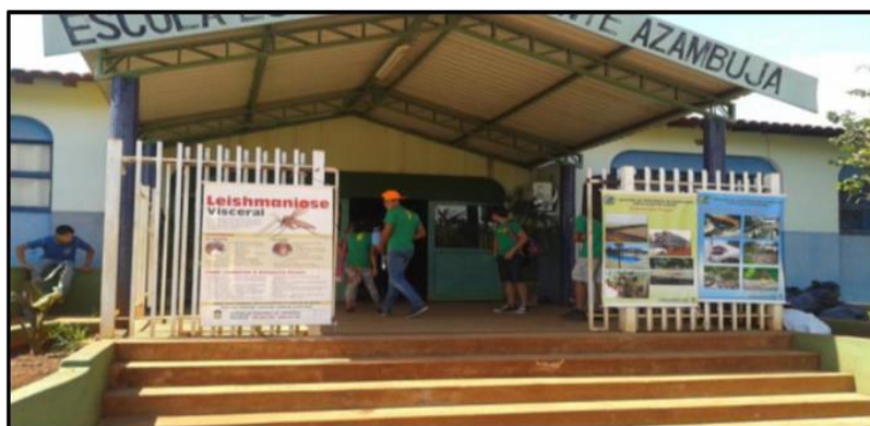
Figura 1 - Vista frontal da EE. Antônio Vicente Azambuja.
