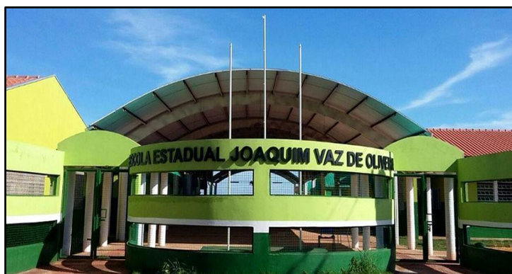
Figura 2 - Vista frontal da EE. Joaquim Vaz de Oliveira.
