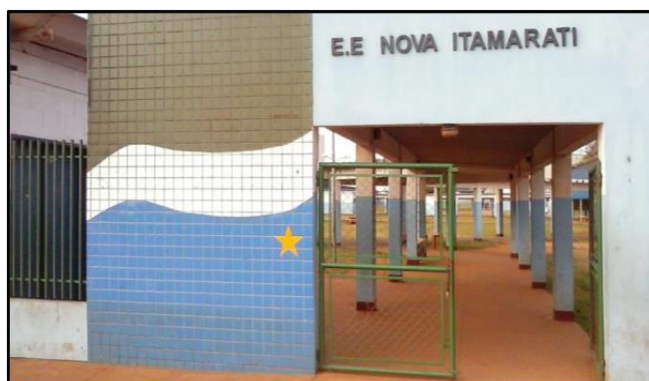
Figura 4 - Vista frontal da EE Nova Itamarati.
