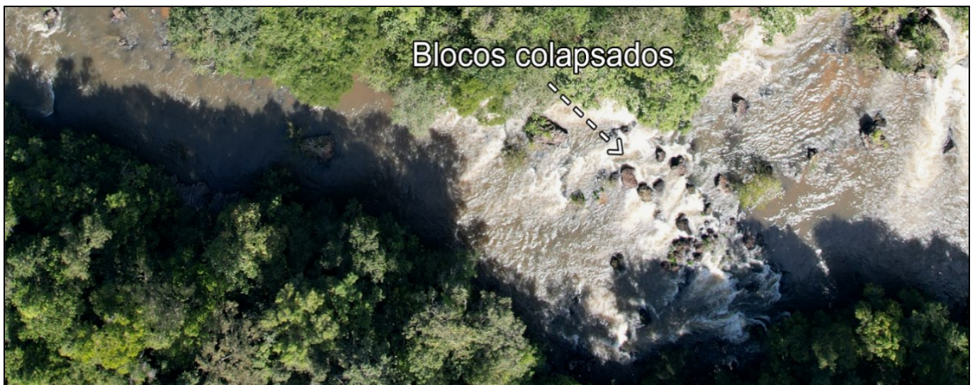
Figura 6: Blocos colapsados ao longo do Rio Ponte de Pedra.
