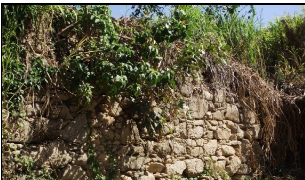
Figura 11 - Detalhe da mesma murada construída com rochas encaixadas, pelos escravos (Fotos: Solange T. de Lima Guimarães, julho/2011)
