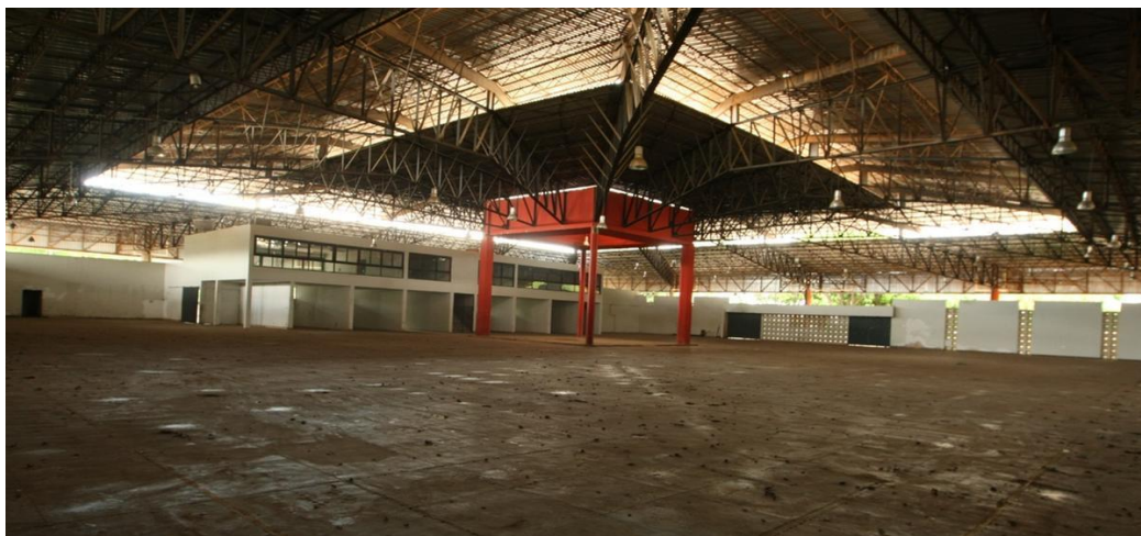
Figura 4 - Espaço interno desocupado do Mercado Distrital do Santa Tereza
