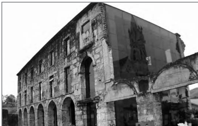
Figura 13 • Rodrigo Meniconi, intervenção nas ruínas do Colégio Caraça (1986-1989), Santa Bárbara. Fonte: Arquivo dos autores.
