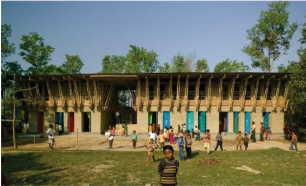
Figura 5 Fachada Oeste - Escola METI.
