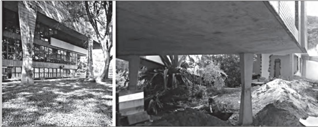
Figura 16 • FAU-USP, arquitetos Vilanova Artigas e Carlos Cascaldi. Fonte: fotografia de Fernando Stankuns. Casa Múcio Souto (1978-1979). Fonte: fotografia de Fillipe Albuquerque Miranda e Davi Pereira Lucena, acervo LPPM-PPGAU-UFPB.
