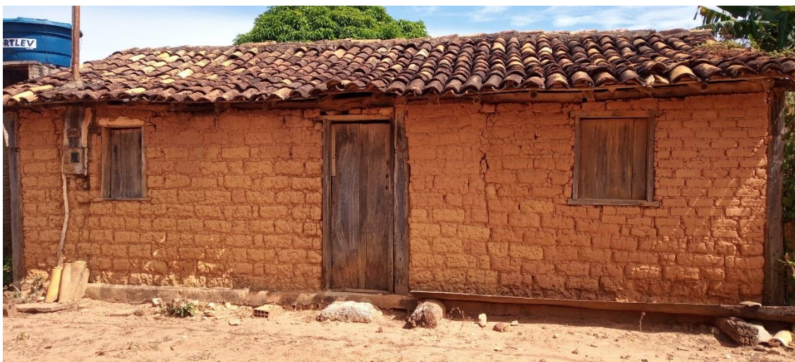
Figura 19 - Edificação de Tipologia Residencial.
