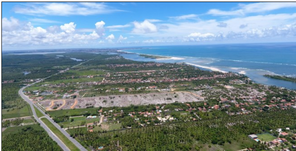
Figura 3 - Vista aérea da desembocadura do CELMM.
