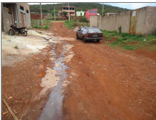
Figura 01 - Presença de esgoto a céu aberto - Rua Galgari
