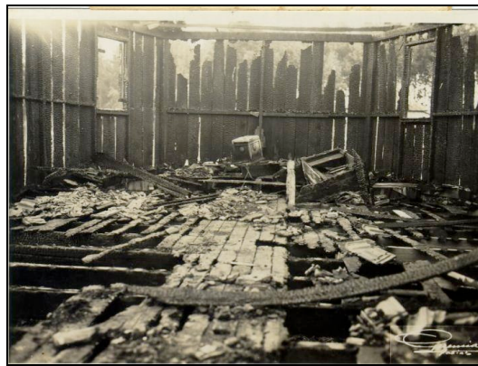
FIGURA 3 INCÊNDIO DA CAPELA
