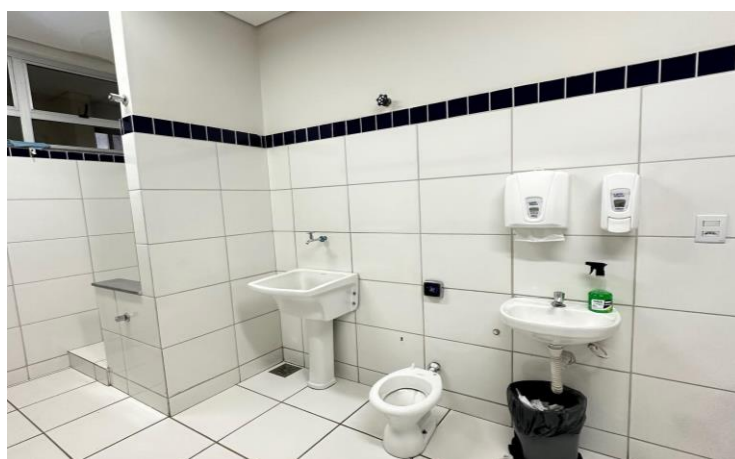
Figura 4 – Banheiro que fica dentro da sala de aula
