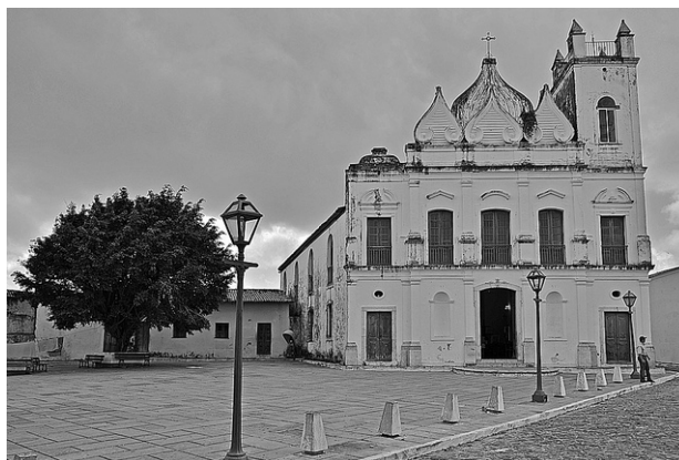
Figura 2 - Igreja Nossa Senhora do Desterro
